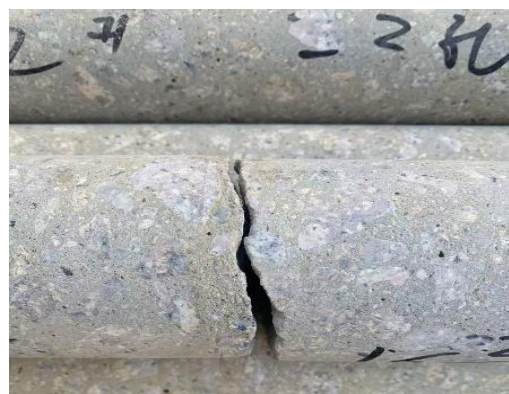
图 3.4.2 孔芯样（缺陷位置）
